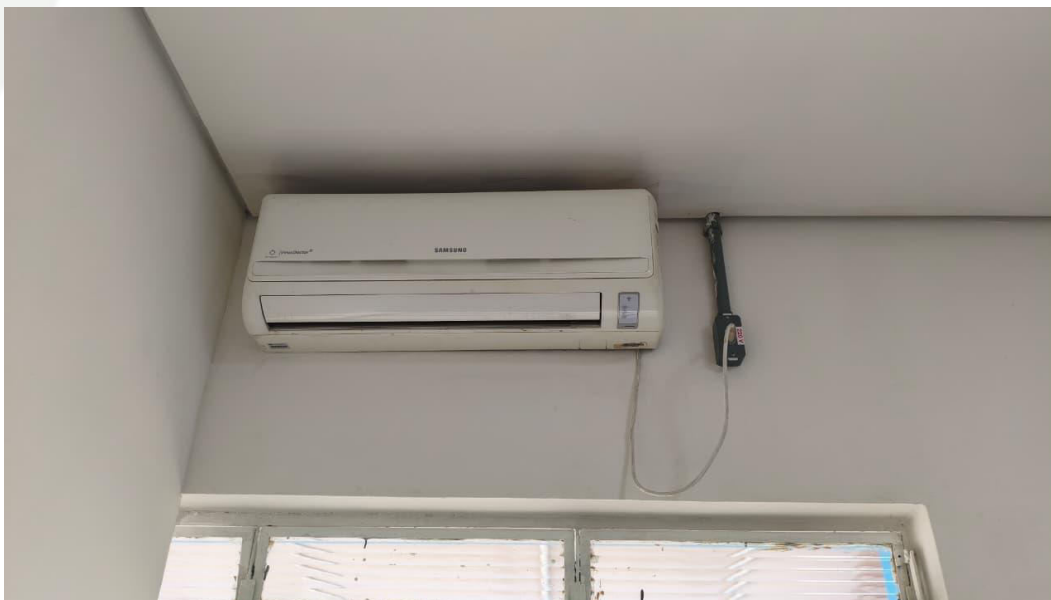
Imagem 3 – Sala da Coord. Adm. e Financeira – Área Interna
