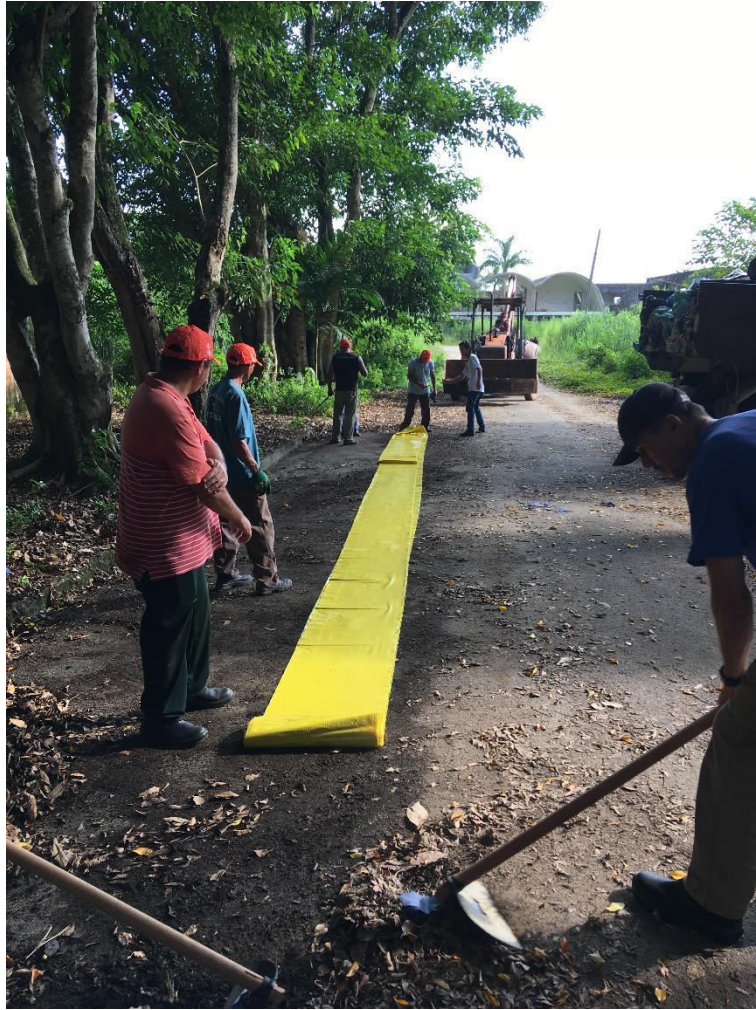
Foto 2: Equipe Preparando o Local para despejo do RSD
